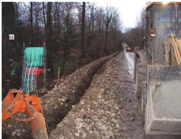
Opérations d'enfouissement des réseaux : les lignes électriques nécessaires au transport de l'énergie des éoliennes vers le point de livraison au réseau sont entièrement mises en souterrain. C'est également le cas du réseau de communication par fibre optique et de mise à la terre.
