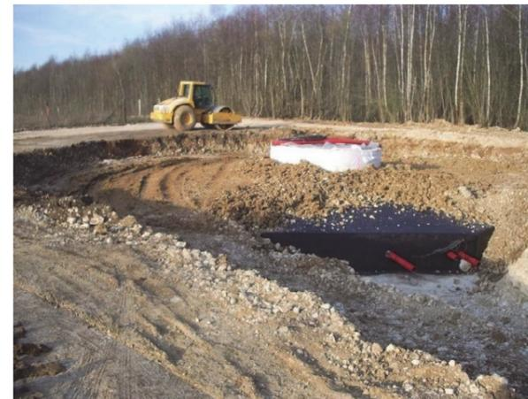
**Remblaiement et compactage** : après séchage, l'excavation est remblayée avec une partie des matériaux excavés et compactée de façon à ne laisser dépasser que la partie haute de l'insert sur lequel viendra se positionner le premier tronçon du mât de l'éolienne.
