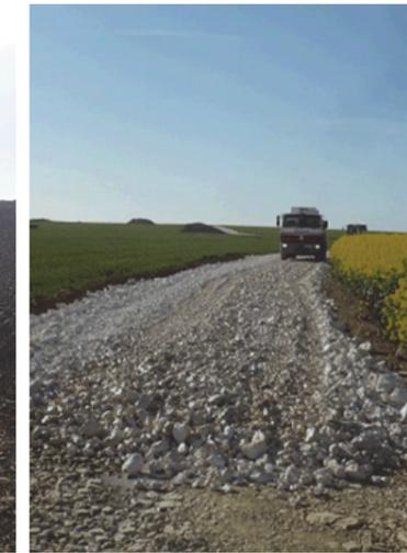
Figure 8: Mise en place de la couche de fond de forme
