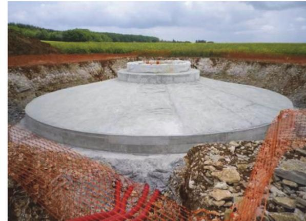
**Fondation terminée** : le massif devra être revêtu d'un produit d'étanchéité (type revêtement bitumineux)
