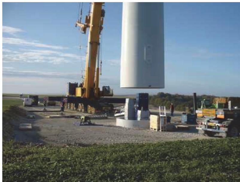
Fixation du premier élément : une fois positionnée verticalement la première partie du mât vient se fixer sur la partie émergente de l'insert.
