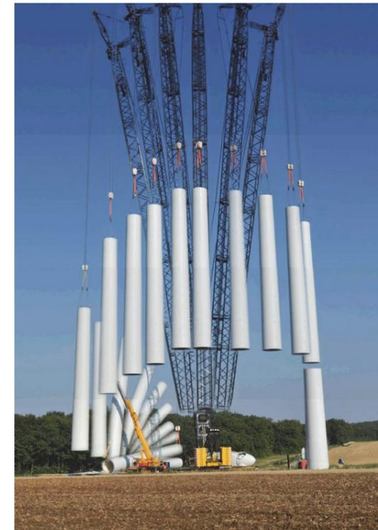
Levage et assemblage des autres tronçons du mât : les mêmes opérations sont répétées pour l'assemblage des tronçons suivants.
