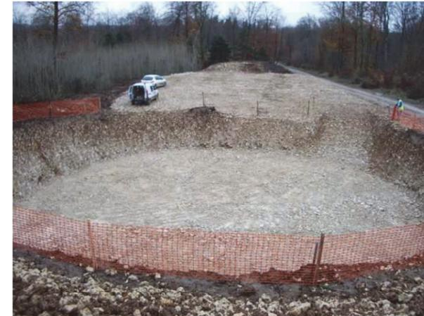
Excavation : à l'emplacement prévu pour l'éolienne, il est réalisé une excavation suffisante pour accueillir la fondation de l'éolienne. Les matériaux de déblai (environ 800 m<sup>3</sup>) sont stockés pour réutilisation si leurs propriétés mécaniques le permettent ou bien évacués vers un centre de traitement adapté.
