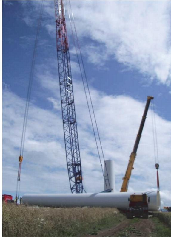
Montage du mât : le mât d'une éolienne est généralement composé de trois ou quatre sections d'acier qui sont assemblées sur place par grutage successif des éléments. Le mât peut également être composé d'une base en béton (coulé sur place ou éléments préfabriqués), avec seules les dernières sections en acier.
