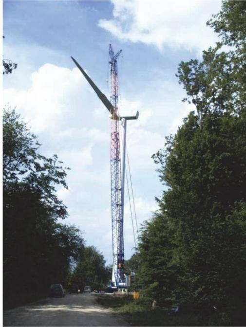
Assemblage des pales et levage du rotor : deux techniques sont envisageables : soit par levage du rotor complet (moyeu et pales assemblés au sol), soit par levage pale par pale. La technique pale par pale sera utilisée afin de limiter les emprises déboisées.
