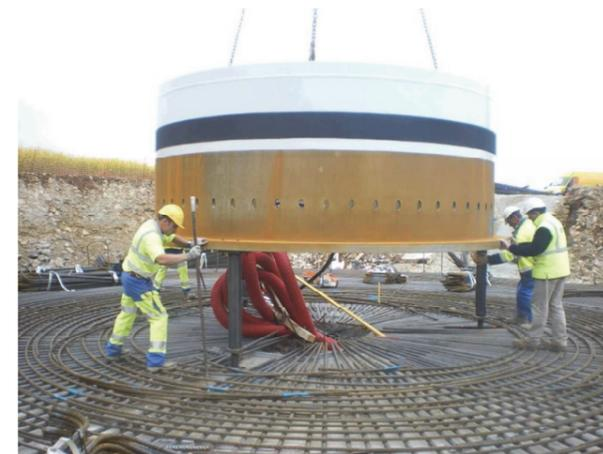
Pose de l'insert : c'est le « support » de l'éolienne. Il est tout d'abord posé sur des plots en béton au centre de la fondation ou sur des pieds métalliques. L'insert est ensuite inclus dans la masse de béton. D'autres techniques remplacent cet insert par un ensemble de couronnes et éléments de ferrailage.
