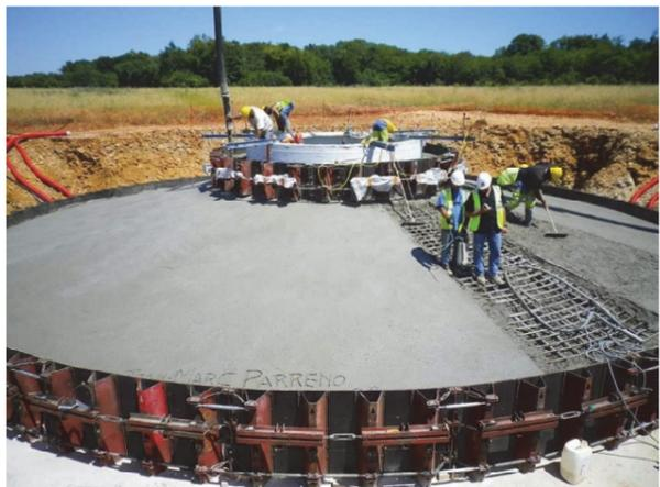
**Coulage** : le béton est ensuite coulé à l'intérieur du coffrage à l'aide d'une pompe à béton. 40 à 45 rotations de toupies par éolienne seront nécessaires pour acheminer sur le site environ 350 m<sup>3</sup> de béton. Sur la phase finale du coulage, un produit de cure devra être mis en place pour éviter la fissuration du béton.
