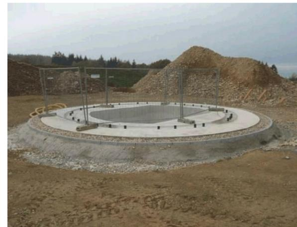
Dans le cas d'une base du mât en béton, cette pièce d'interface se situe en hauteur. La partie superficielle de la fondation est alors lisse.
