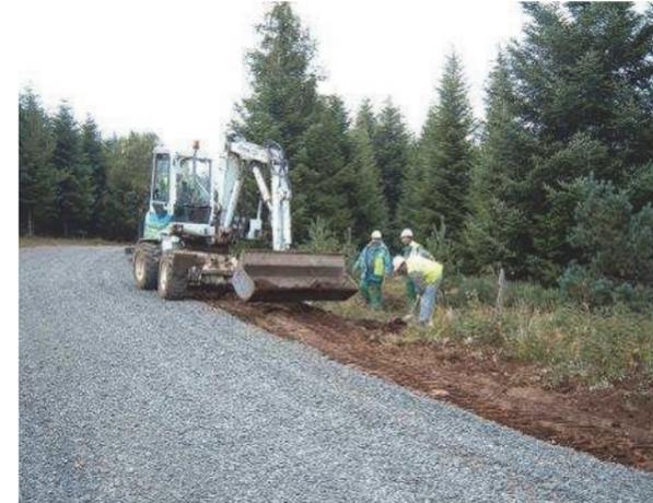
Fermeture de tranchée : une fois le câble déroulé dans la tranchée celle-ci est rebouchée et compactée et le bas-côté est remis en état. L'intégralité des matériaux extraits est régalé sur place afin d'éviter leur évacuation.
