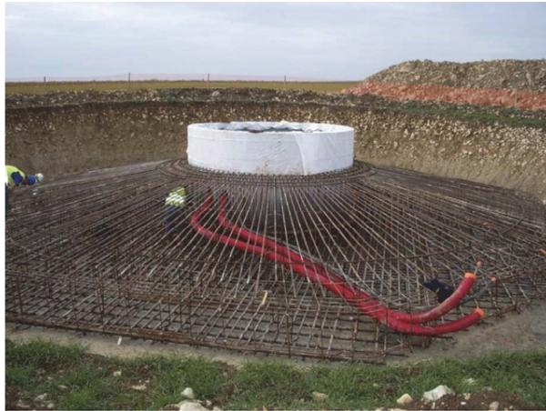
**Ferrailage** : avant d'effectuer le coulage du béton, il faut réaliser l'armature métallique qu'il va renfermer (environ 35 tonnes). Cette armature rendra le futur massif de béton extrêmement résistant.
