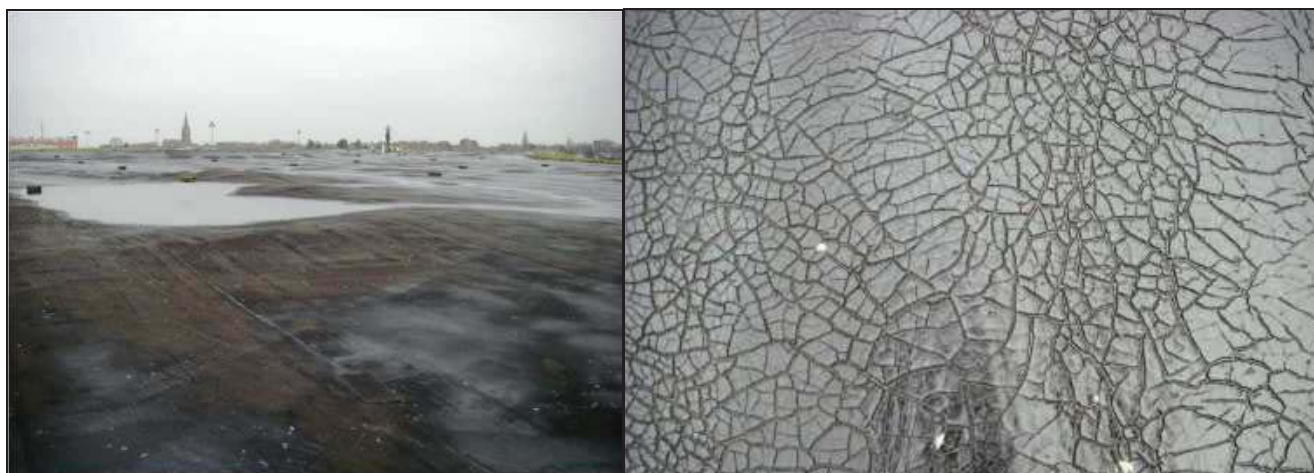
Figure IV. 2.2 : Géomembrane bitumineuse du terriL de Wattrelos
