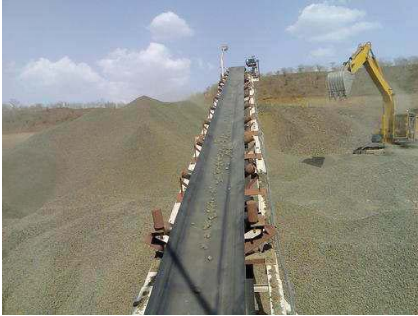
Figure III. 1.6 : Exemple de convoyeur à bande (ici non couvert)
