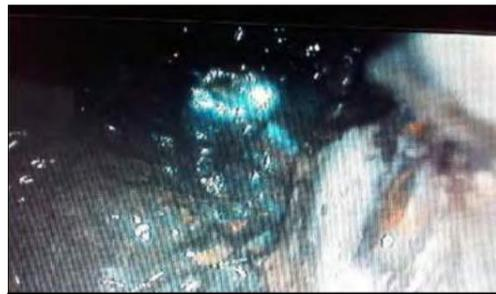
Drain B : rupture de canalisation à 60 cm, faible d'écoulement
