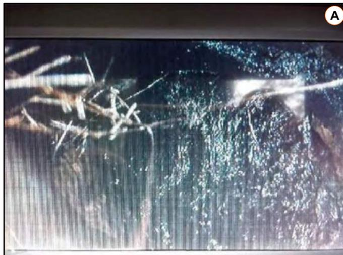
Drain ou arrivée de la Source 1? : rupture de canalisation à 2,2 m, très faible écoulement
