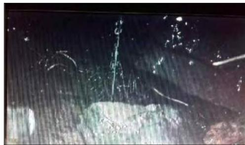
Drain D : rupture de canalisation à 1 m, faible d'écoulement
