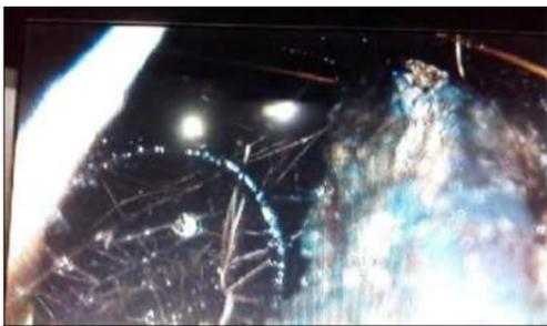
Drain C : rupture de canalisation à 1,5 m, écoulement
