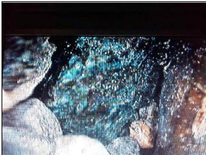
Inspection vidéo du drain de la source 4 : Rupture totale de canalisation à 20 cm : aucun écoulement
