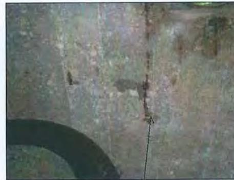
Ferrillage corrodé au niveau de la face interne du toit
