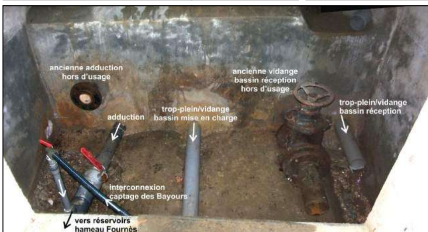
Vues intérieures du captage
