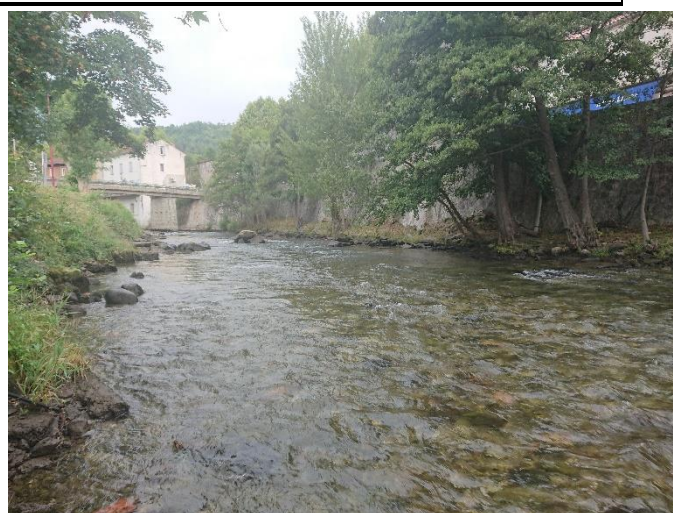
Alternance Courant / Profond induite par les déflecteurs en milieu de station.
