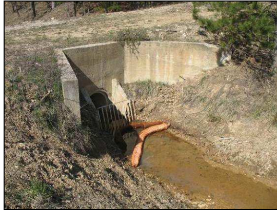
Figure 132 : Exemple d'utilisation d'un boudin dédié à l'absorption des hydrocarbures (Source : J. BAILLEAU, ECOMED)
