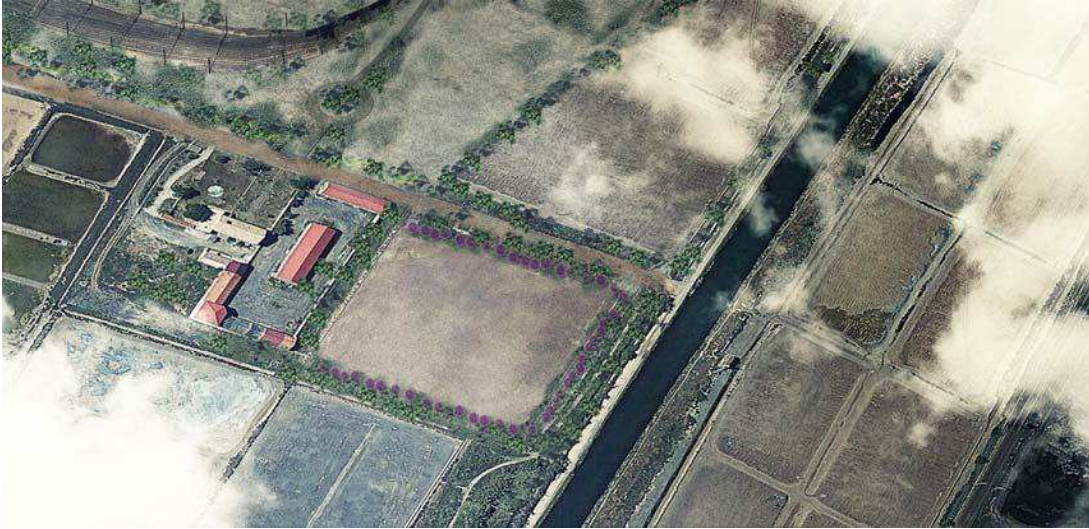
Figure 171 : Perspective du site – vue aérienne de l'ensemble depuis le Nord-Ouest (vue 10)
