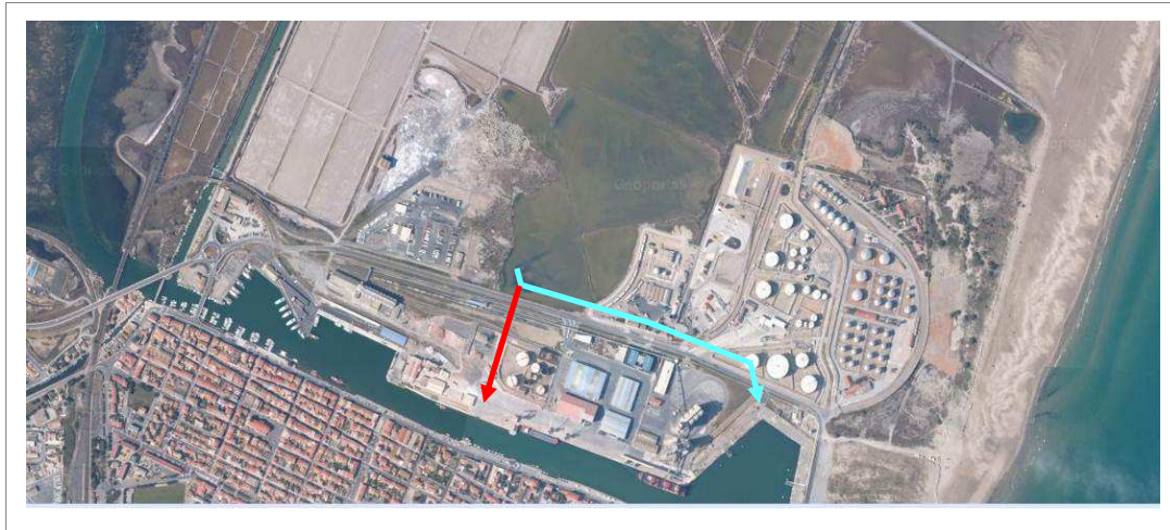
Figure 137 : Localisation du rejet du BV 2 dans la darse pétrolière
