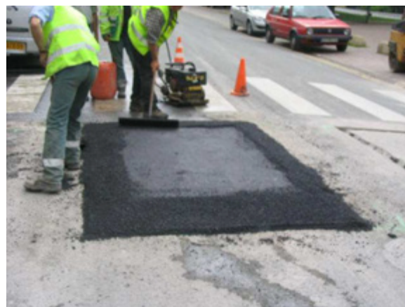
4. Retrait du cadre de moulage, application de la couche d'accrochage pour les rampants, mise en place et prémoulage de la quantité d'enrobé nécessaire aux rampants. (Source : Lille Métropole)
