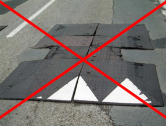
Coussins en caoutchouc dégradé. (Source : Kéolis-Lyon)
