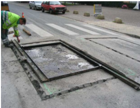
1. Création de la saignée de contour aux dimensions extérieures du coussin et mise en place du cadre permettant de créer la partie centrale. Cadre à épaisseur constante, adaptable aux dimensions. (Source : Lille Métropole)
