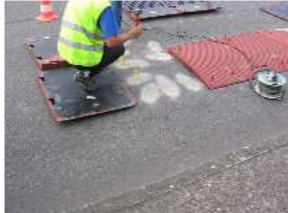
2. Mise en place des chevilles de fixation. Application d'un matériau collant. (Source : Certu)
