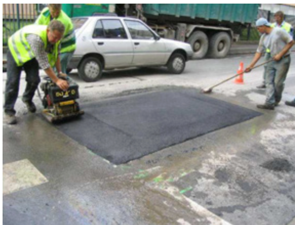
5. Compactage des rampants à la dame vibrante, avec une seconde personne qui prend appui sur la dame pour réaliser des arêtes bien vives. (Source : Lille Métropole)
