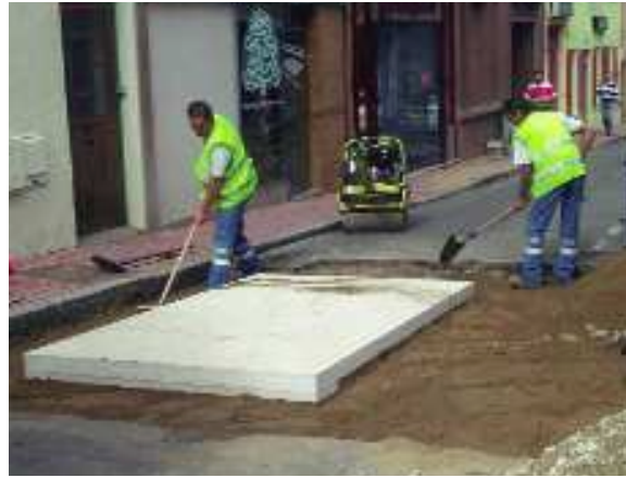
2. Traitement des abords du coussin. (Source : Certu)
