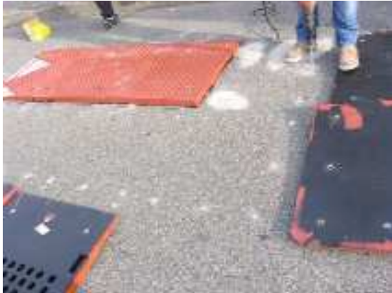
1. Délimitation de la surface d'implantation. Perçage des emplacements de fixation sur la chaussée. (Source : Certu)
