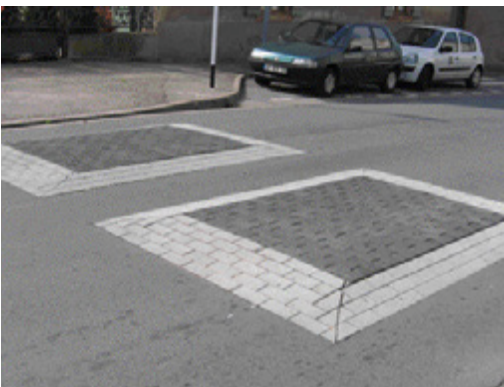
Coussin en matériaux modulaires. (Source : Cete de l'Est)
