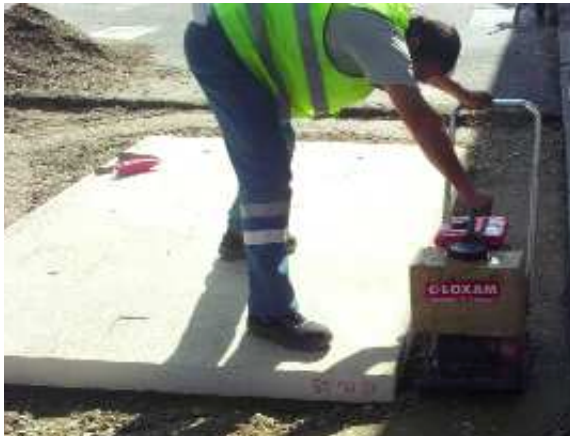
3. Compactage. (Source : Certu)
