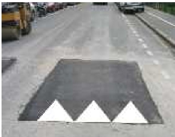
6. Détail du raccord entre la chaussée et le coussin, application éventuelle en surface d'une résine de couleur différenciée de celle de la chaussée, mise en œuvre du marquage des dents de requin sur les rampants, puis remise en circulation dès la fin de mise en œuvre. (Source : Lille Métropole)
