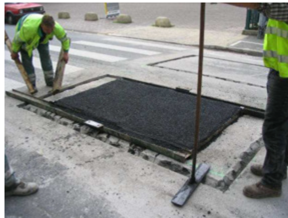
2. Application de la couche d'accrochage pour la partie centrale : mise en place de la quantité d'enrobé nécessaire à la forme centrale du coussin et étalage uniforme de l'enrobé. (Source : Lille Métropole)
