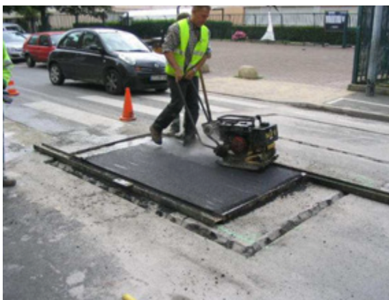
3. Compactage de l'enrobé à l'aide d'un rouleau, puis finition des contours à la dalle vibrante. (Source : Lille Métropole)
