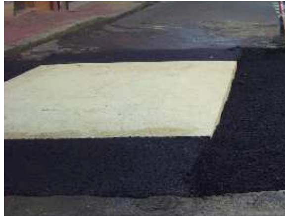
4. Coulage d'enrobé autour du coussin. (Source : Certu)
