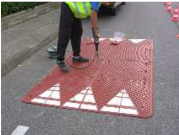
3. Vissage des éléments de fixation. (Source : Certu)
