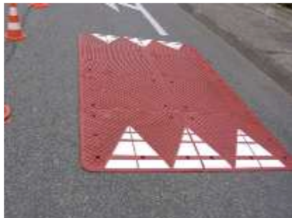
4. Après la réalisation de l'implantation, on s'assure de la tenue solide des plaques et de la bonne jointure entre elles. (Source : Certu)
