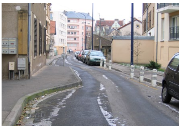
Mise en place d'une chicane permettant la réduction des vitesses et la continuité des cheminements piétonniers
