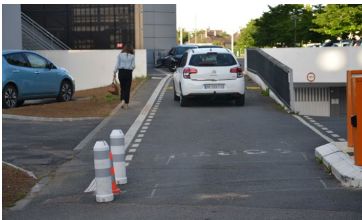
Un espace dédié aux piétons réalisé pour accéder aux bâtiments depuis le parc de stationnement
