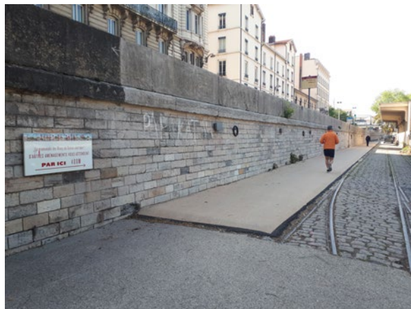
Ajout d'une résine pour la continuité piétonne sur un espace peu confortable et glissant
