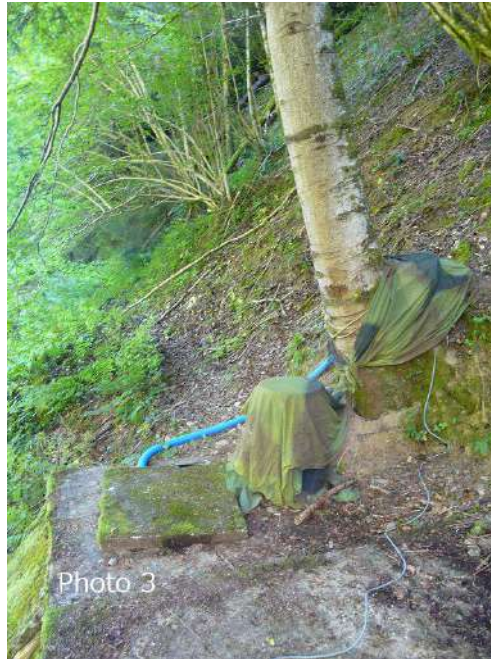
Photo 3. Installation du fluorimètre et du préleveur automatique à la source de Merial
