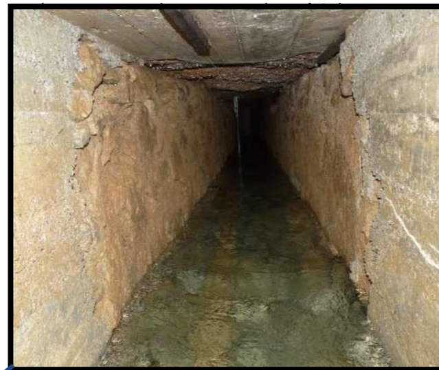
Photo 7 : Couloir du canal d'amenée
