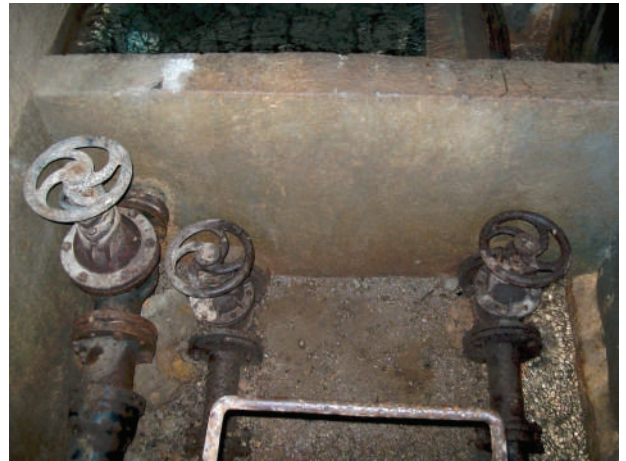
Chambre des vannes
