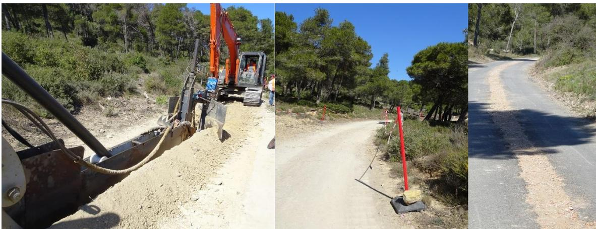
Trancheuse qui installe la canalisation à gauche, balisage des milieux naturels au centre et rendu une fois la canalisation installée au niveau d'une zone revêtue à droite – CBE, 2021
