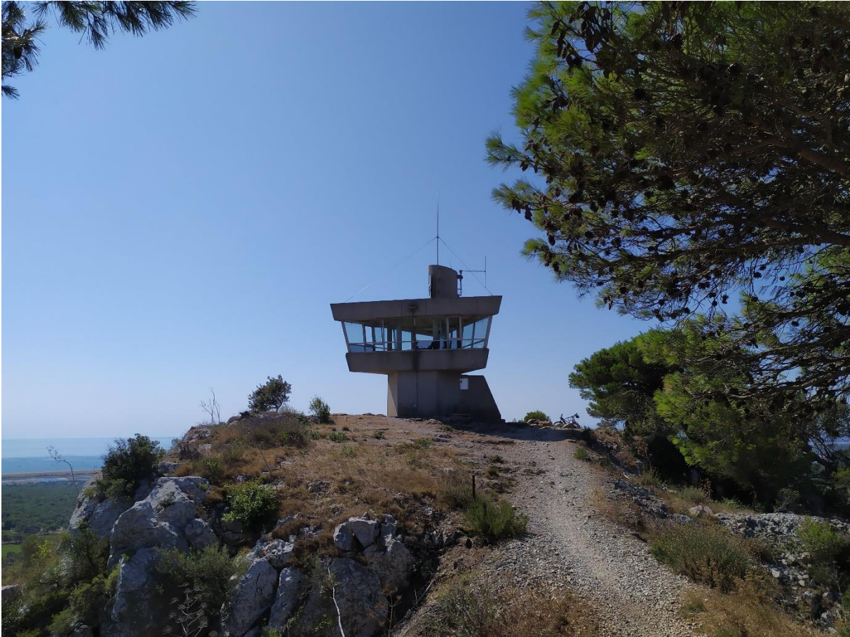
Figure 25 : Vigie Gruissan - Face Nord - Vue éloignée
