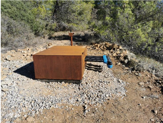
Figure 24 : Exemple de bornes d'irrigation dans le massif de la Clape
