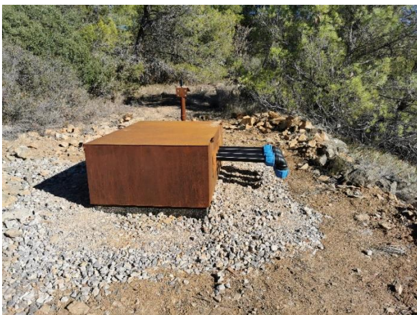
Figure 23 : Exemple de bornes d'irrigation dans le massif de la Clape
