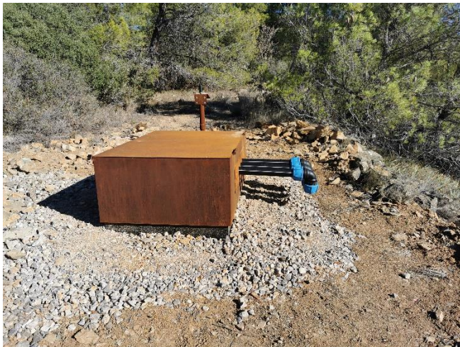
Figure 1 : Exemple de bornes d’irrigation dans le massif de la Clape
