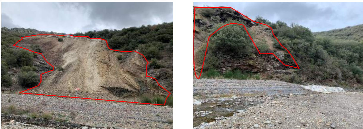
Figure 35. Vues du pied de verse de Nartau et des gabions (ENVISOL)
