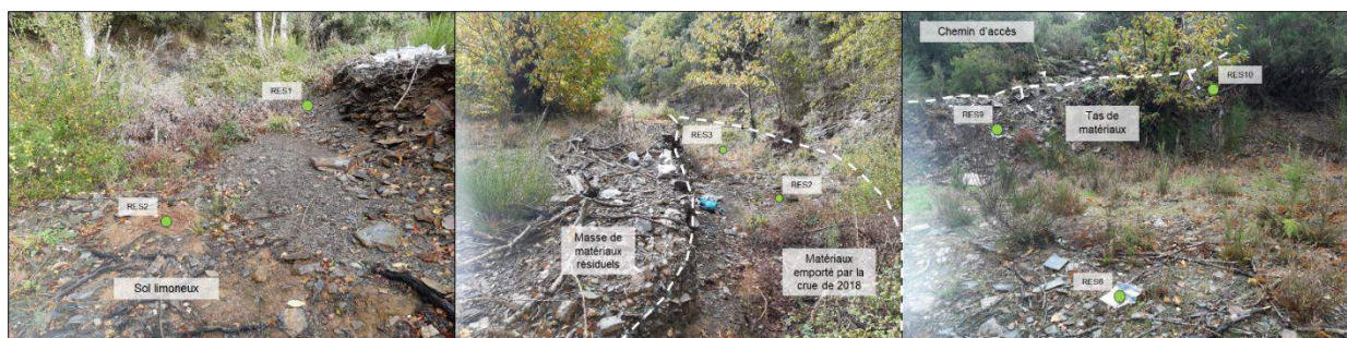
Figure 49. Photographies des zones échantillonnées au droit de la zone de résidus de four de Nartau.
