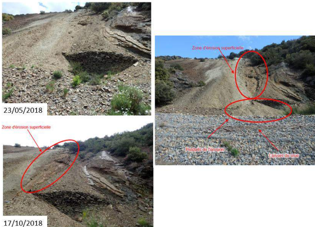
Figure 40. Erosion superficielle des matériaux de la verse de Nartau observée lors des pluies exceptionnelles d'Octobre 2018 (BRGM, 2019)
