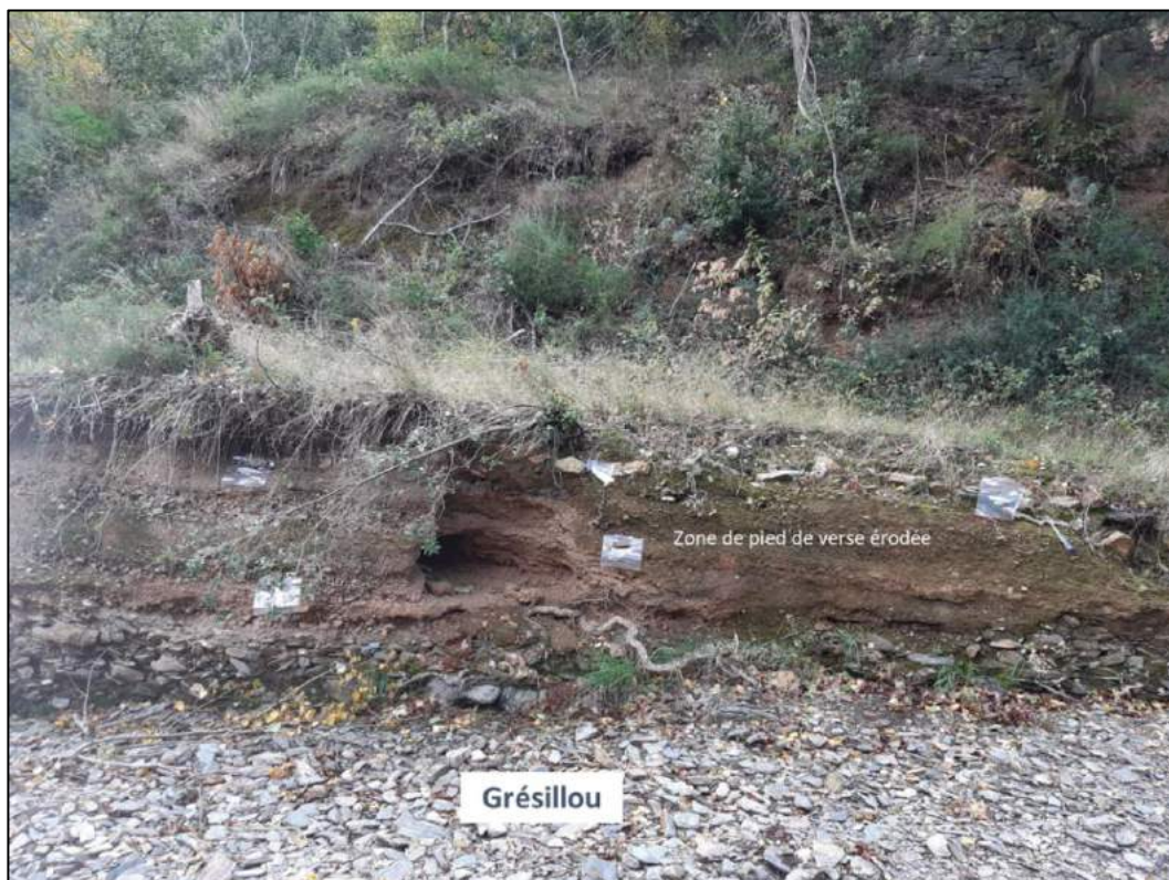
Figure 56. Illustration de la verse de Ramèle et de la zone érodée en pied de verse.
