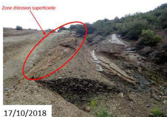
Figure 57 : Erosion superficielle des matériaux de la verse de Nartau observée lors des pluies exceptionnelles d'Octobre 2018 (BRGM, 2019)
