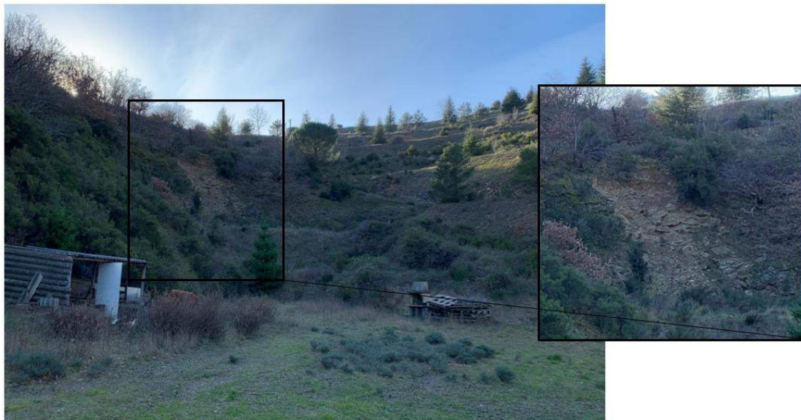
Figure 55 : Effondrement observé au droit de la galerie d'aérage Ramèle (Janvier 2020).
