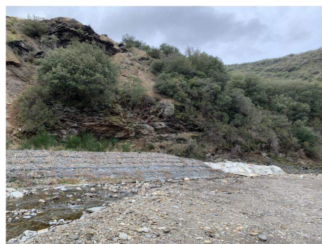
c) gabions en bon état en pied de verse
