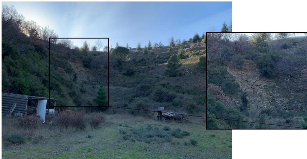
Figure 63. Effondrement observé au droit de la galerie d'aérage Ramèle (Janvier 2020)
