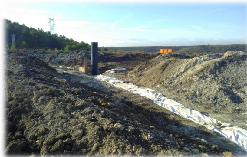
Puits et tranchée drainante
