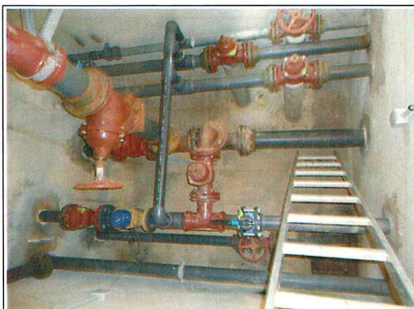
Le génie civil de la cuve et la chambre des vannes sont en très bon état. Il existe un compteur d'adduction équipé d'une tête émettrice qui est relié au traitement. Toutefois ce compteur n'est pas fiable. Il comptabilise, d'après la mairie et après vérification 5 fois plus que le volume arrivant réellement.
