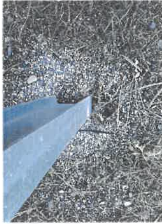
Vue d'un pieu battu
