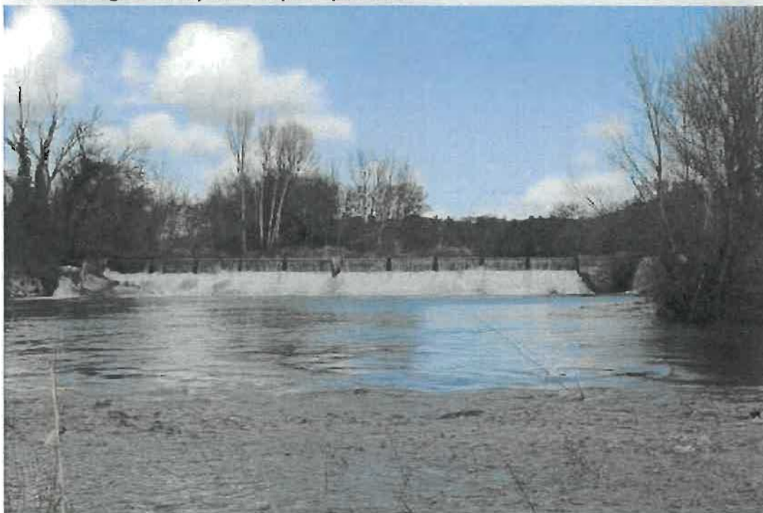
Vue du barrage et de la passe à kayak depuis l'aval
