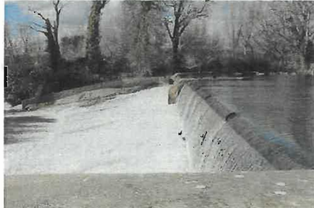
Barrage de Villedubert
