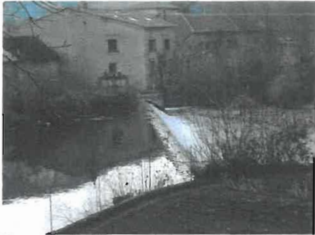
Photo numéro 3, vue sur le barrage, embarquement possible par l'ancien passe à poissons sur la rive gauche.
