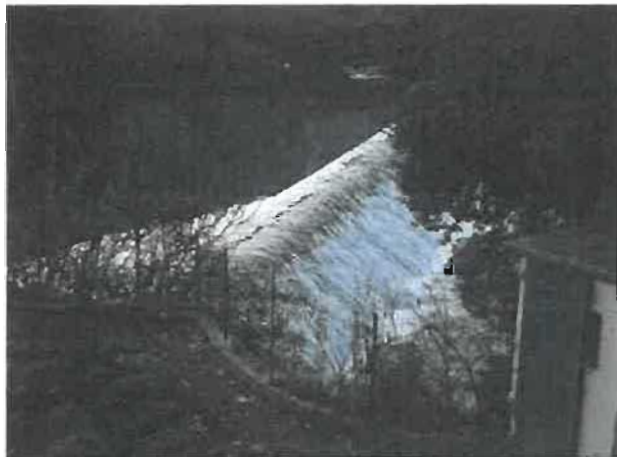
Photos numéro 4 et 5, endroit pour signaler pour le passage à canoë/kayak.
