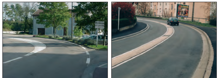
Exemples de surlargeurs axiales franchissables par les poids lourds.
