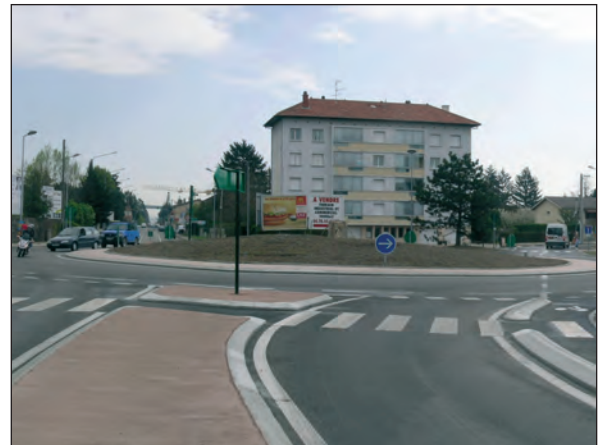
Exemple d'îlot de protection des cyclistes en entrée de giratoire.
