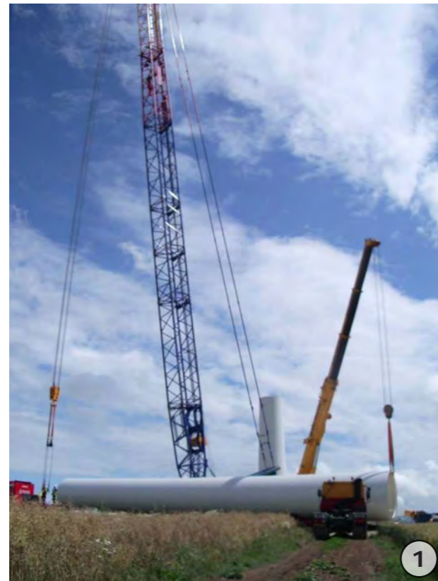
1 Levage des éléments avec deux grues (Source : EOLE-RES).
