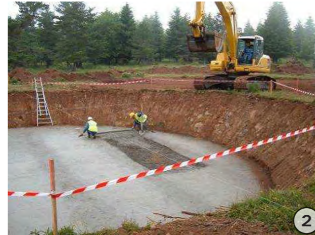
Sous couche d'environ 30m 3 de béton de propreté (Source : EOLE-RES).
