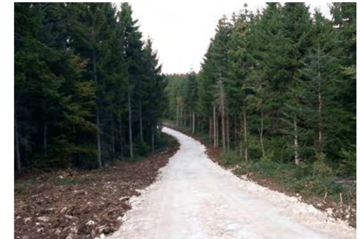
Exemple de piste après aménagement (source EOLE-RES).
