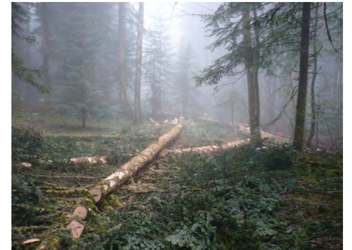
Piste après abattage (source EOLE-RES).
