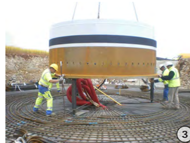
L'insert est le support de l'éolienne (Source : EOLE-RES).
