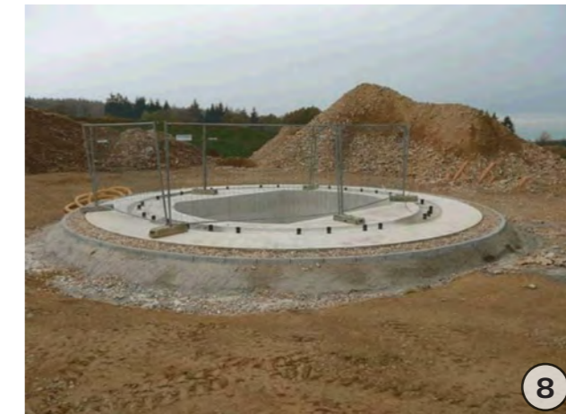
Après remblaiement et compactage, seule l'embase du mât, d'un diamètre de 7,5 mètres maximum, sera visible au sol. La semelle béton, d'un diamètre de 20 m environ sur 3 m de profondeur, est enterrée et non visible (Source: EOLE-RES).
