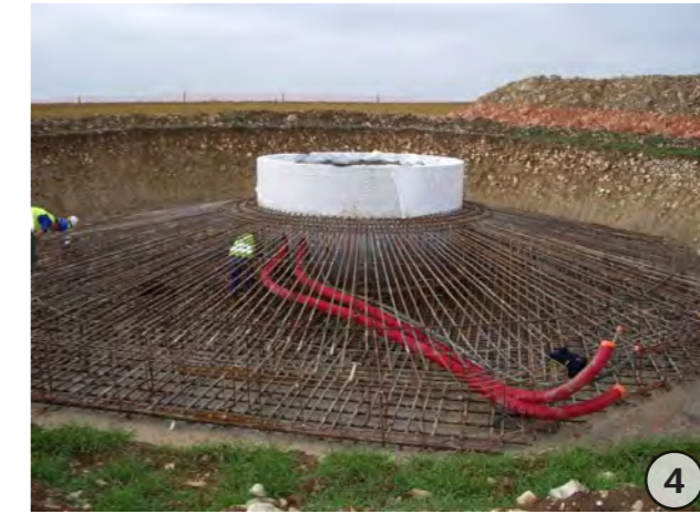
Pose de l'armature métallique (Source : EOLE-RES).
