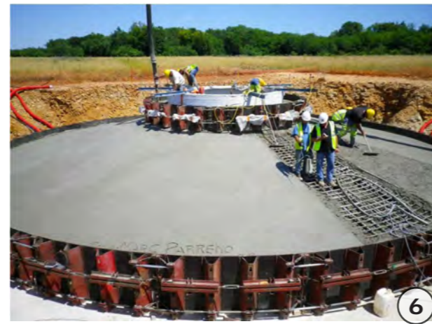
Coulage de 350 m 3 de béton (Source : EOLE-RES).
