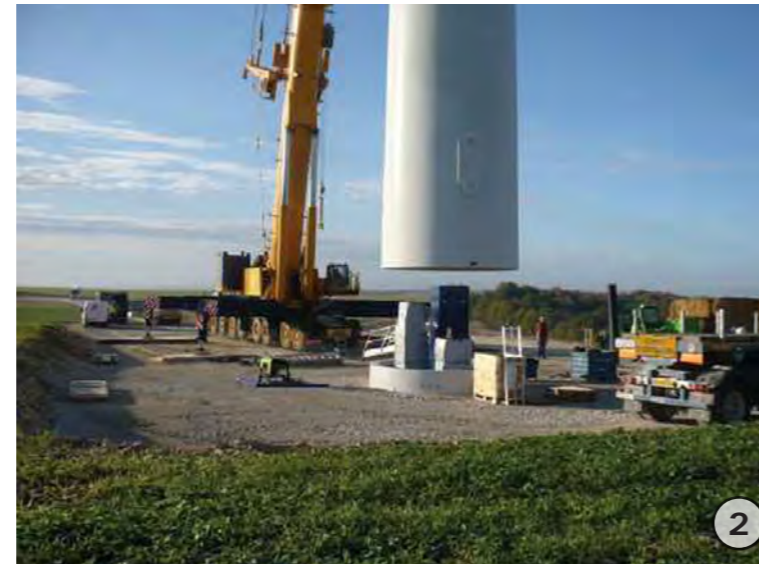
2 Fixation du mât sur le support (Source : EOLE-RES).
