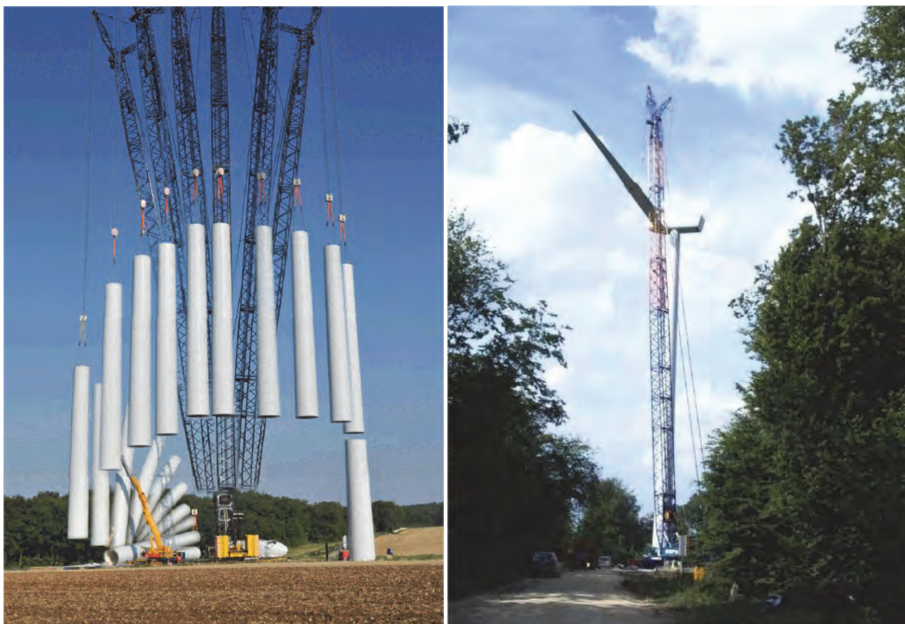
Montage des éoliennes
