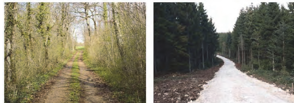
Exemple de piste avant aménagement
