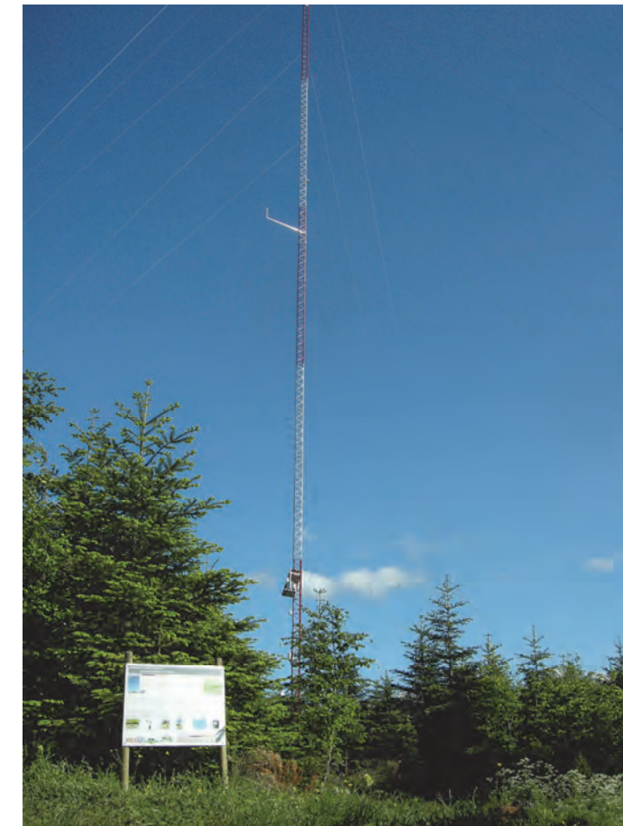
Photographie 48 : Le mât de mesures anémométriques sur le site du projet des Fanges (source EOLE-RES)
