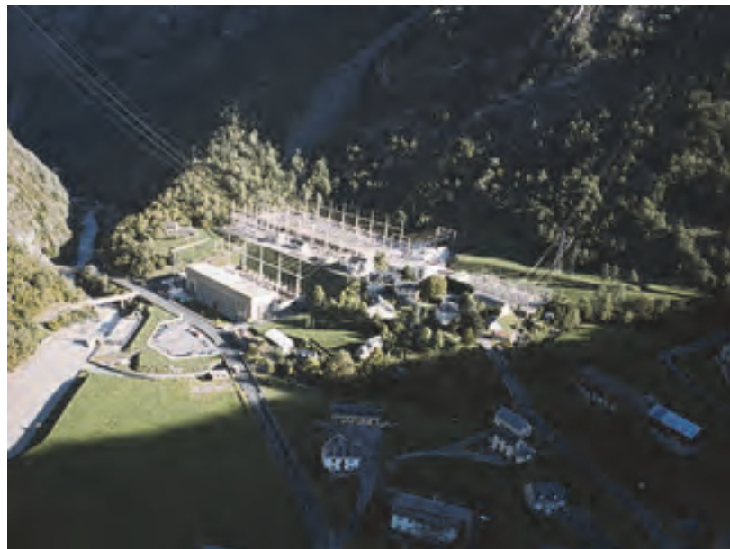
Photographie 46 : Centrale hydroélectrique de Nentilla (source EDF)
