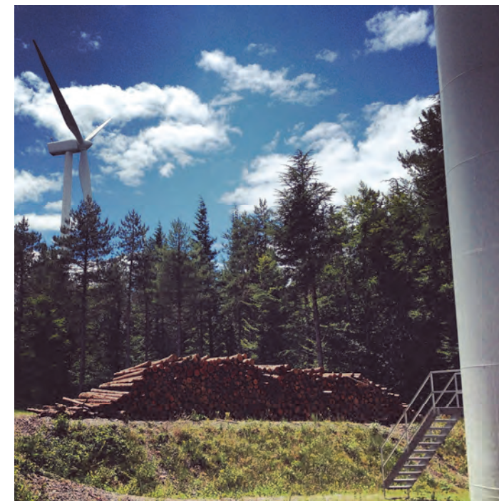
Figure 128 : Située au pied des éoliennes, place de dépôt servant au stockage provisoire du bois avant son chargement sur un grumier (source EOLE-RES)
