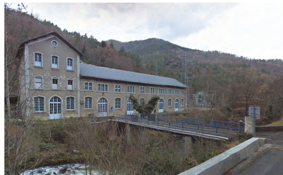
Photographie 49 : Le poste électrique de Saint-Georges (source Google Street View)
