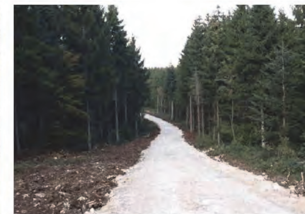
Exemple de piste après aménagement
