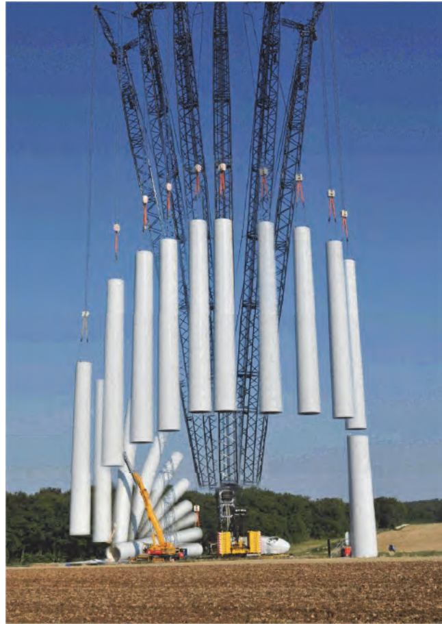
3) Levage et assemblage des autres tronçons du mât : les mêmes opérations sont répétées pour l'assemblage des tronçons suivants.
