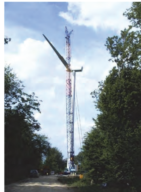
5) Assemblage des pales et levage du rotor : deux techniques sont envisageables : soit par levage du rotor complet (moyeu et pales assemblés au sol), soit par levage pale par pale. La technique pale par pale sera utilisée afin de limiter les emprises déboisées.
