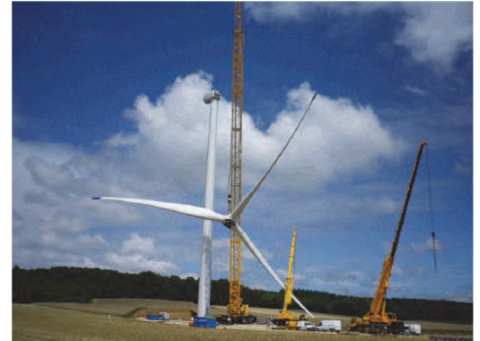
5) Assemblage des pales et levage du rotor : deux techniques sont envisageables : soit par levage du rotor complet (moyeu et pales assemblés au sol), soit par levage pale par pale. La technique pale par pale sera utilisée afin de limiter les emprises déboisées.
