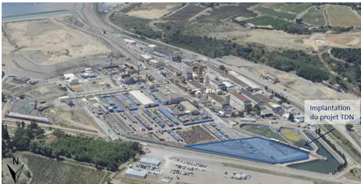
Figure 1 : Vue aérienne de l'implantation du projet TDN
