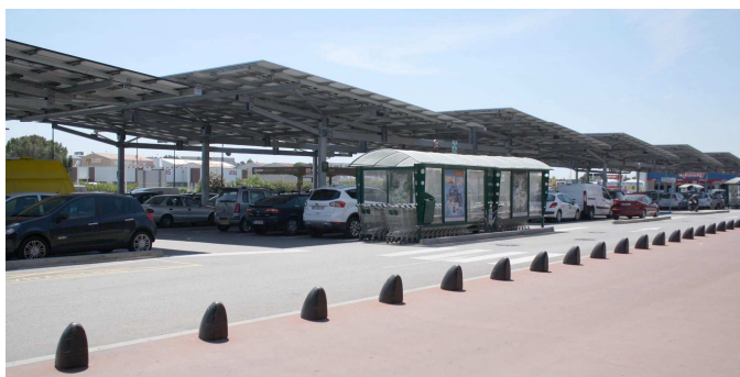
Ombrière de parking, Centre commercial à Narbonne
