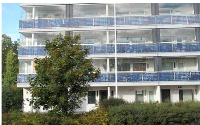
Réhabilitation de logement social Panneaux insérés en tant que garde corps
