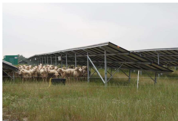
Exemple parc Élément Power – St-Martin-Lalande
