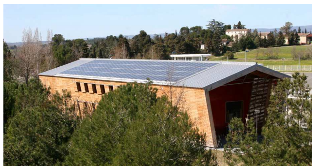
Toiture photovoltaïque CAUE de l'Aude - Carcassonne
