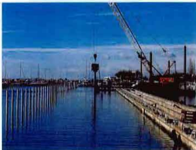
Photo 47 - grue sur ponton munie d'un appareil de vibro-fonçage
