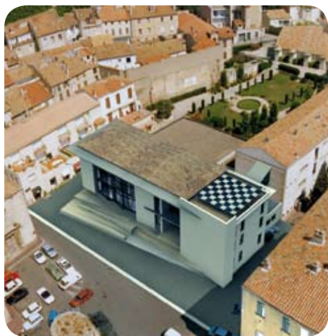
Toiture photovoltaïque en damier sur la MJC de Narbonne - architecte : atelier 2Ai - Yvan Tognella architecte.
