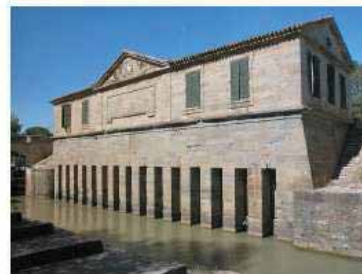
L'épanchoir de Gaillousty, une construction remarquable sur le Canal de Jonction (mai 2006).
