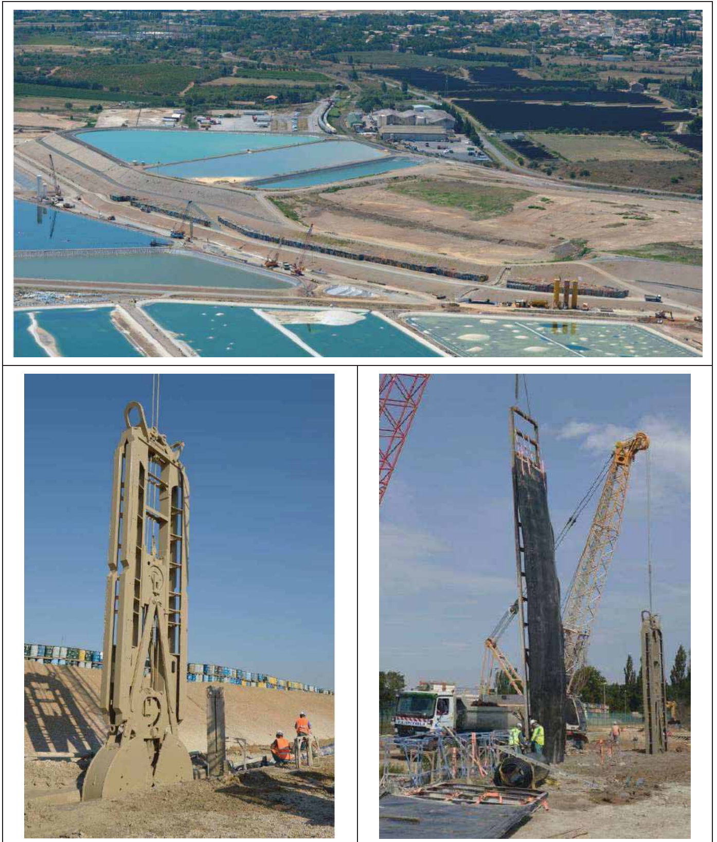
Figure II. 6.5 : Vues photographiques du chantier de réalisation de la paroi souterraine
