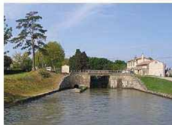
Sortie d'une écluse sur un bief audois du Canal (mai 2006).
