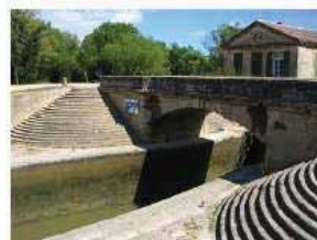
L'écluse de Gaillousty, ouvrage très esthétique sur le Canal de Jonction. (mai 2006).
