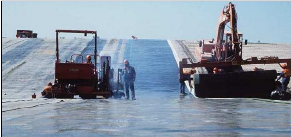
Exemple de chantier de pose d'une couverture bitumineuse (Source : centre de stockage des déchets radioactifs de la Manche, 1993)
