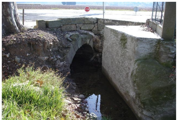
8-Franchissement de la RD85 par le Ruisseau de Maire
