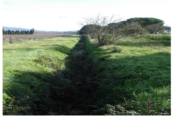
4-Fossé drainant le Carrétal le long du canal
