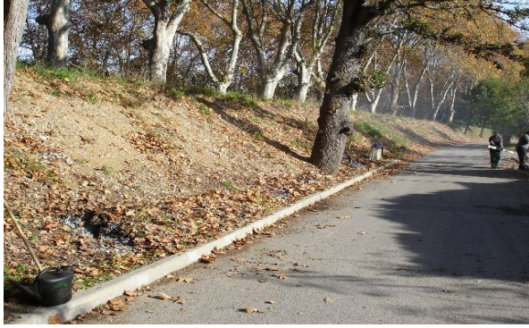
9-Digue au droit de lotissement les berges du canal
