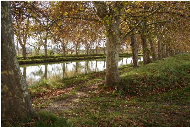
11-Point bas de la digue de canal (berge nord)
