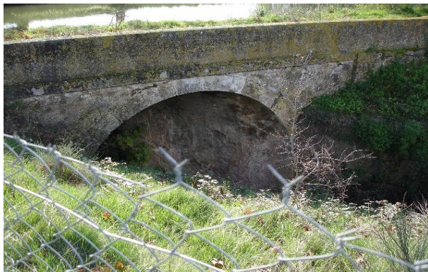
13-Siphon de la rigole de l'étang de Jouarres sous le canal
