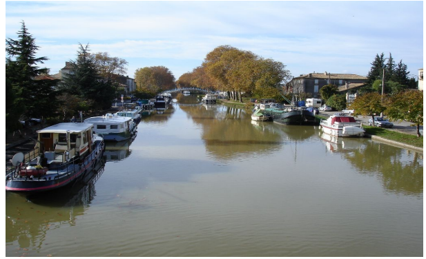
10-Quais du port de puis le pont de la RD610
