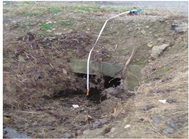
6-Franchissement de fossé sous la RD 610
