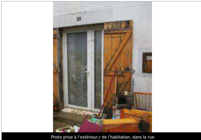
Photo prise à l'extérieur, r de l'habitation, dans la rue
