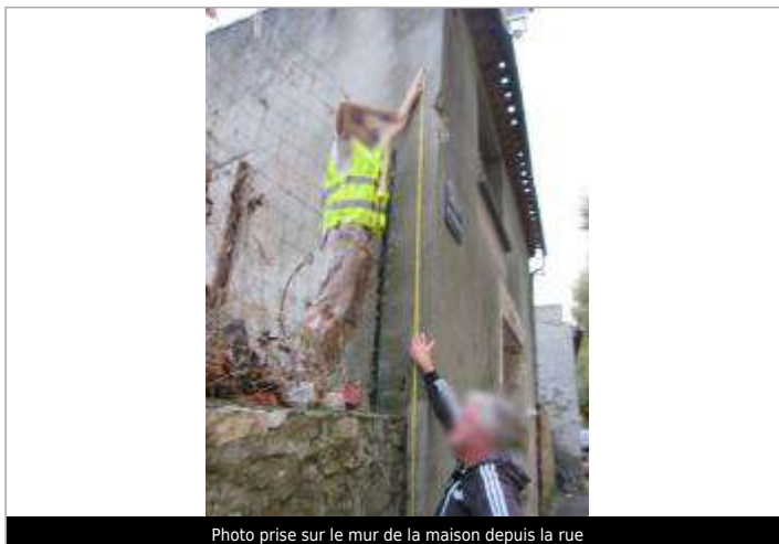
Photo prise sur le mur de la maison depuis la rue
