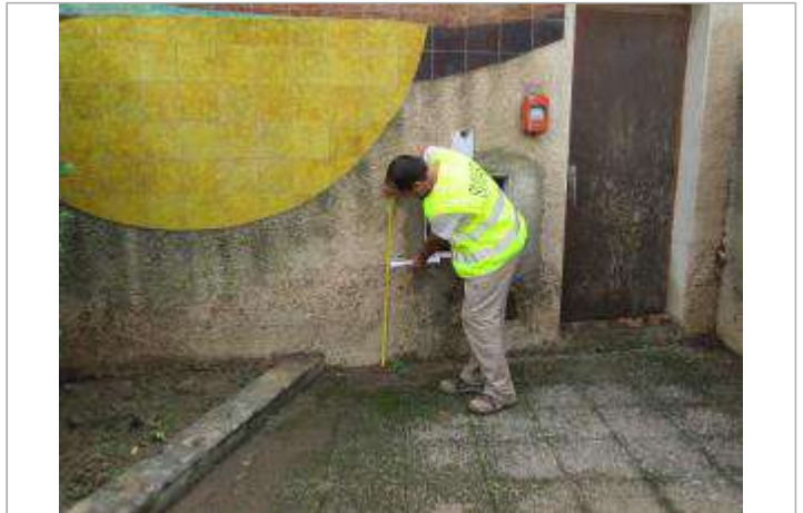
Photo prise à l'extérieur, sur le mur de l'école
