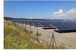
Centrale installée sur une friche : les vues plongeantes sur le site depuis la route voisine sont préservées par un merlon végétalisé préexistant (à gauche de la vue). © Wolfgang Borst
