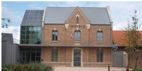
Construction photovoltaïque rapportée, mairie de Raillencourt-Sainte-Olle. © Mairie de Raillencourt
