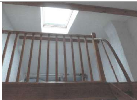
Pose d'une fenêtre de toit sur une mezzanine existante (avant/après)
