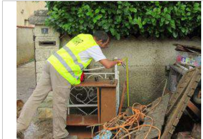
Photo prise à l'extérieur, sur le mur de clôture
