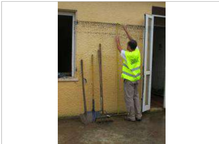
Photo prise sur le mur de la maison
