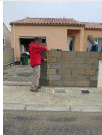
Photo prise à l'extérieur, à partir de la rue
