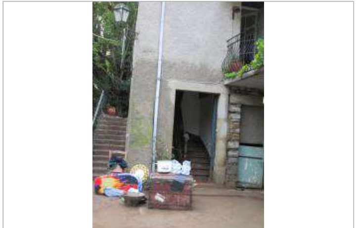
Photo prise sur le mur de la maison
