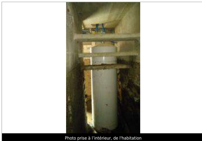
Photo prise à l'intérieur, de l'habitation
