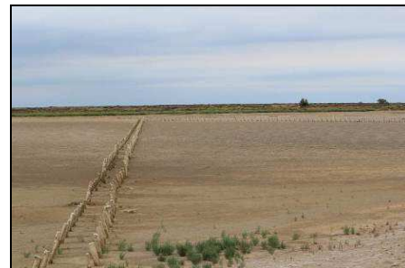
Lagune industrielle C. SAVON, 07/08/2013, Port-La Nouvelle (11)
