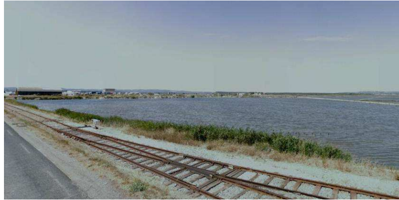
Figure 102 : Vue de la zone de projet depuis l'entrée du port de commerce (RD 703)
