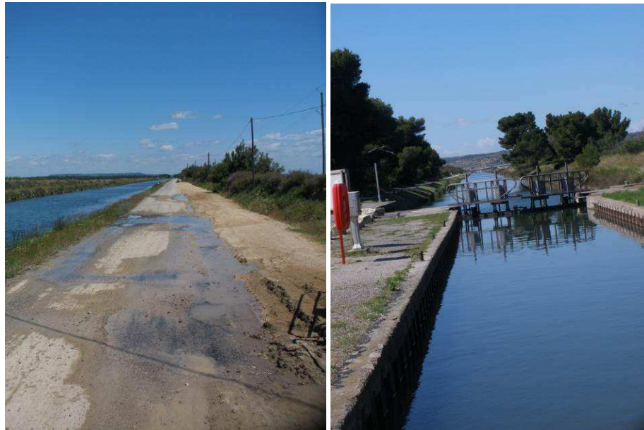
Photos EGIS EAU juin 2011
