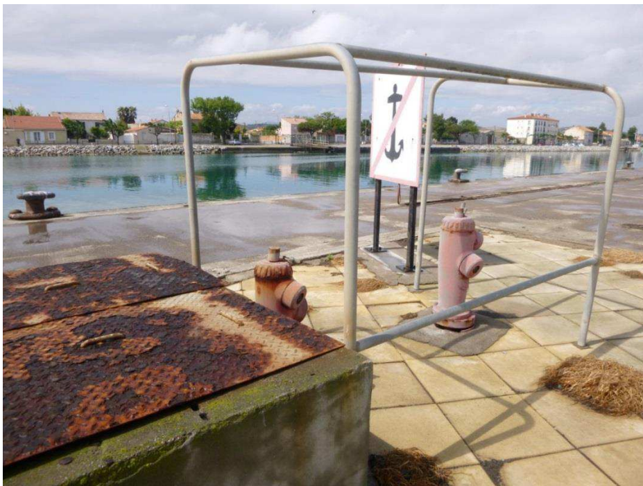
Photo 5 : Poteau incendie sur l'extrémité Est du tronçon D
