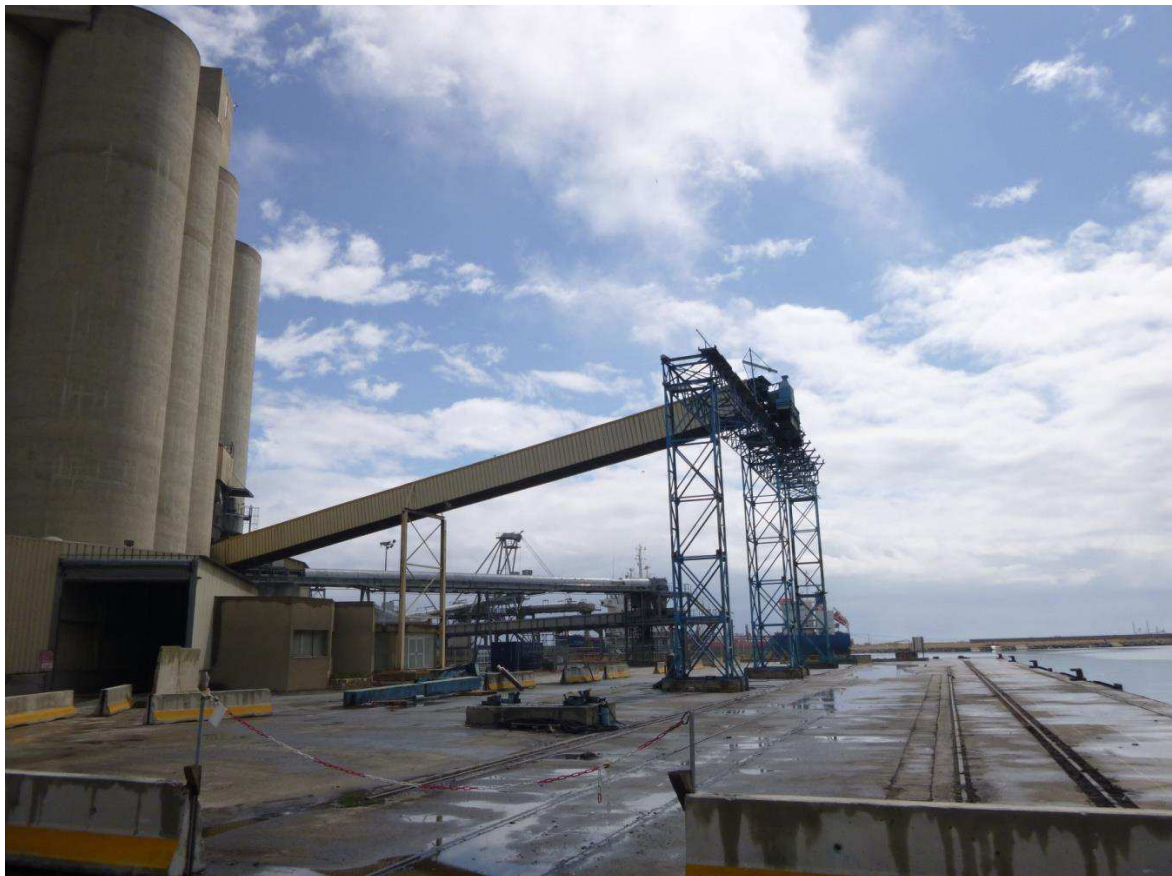
Photo 3 : Equipements actuels des silos du Sud sur les tronçons C et D
