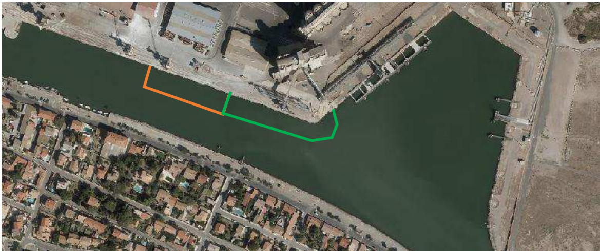
Figure 28 : Localisation du barrage anti-MES
