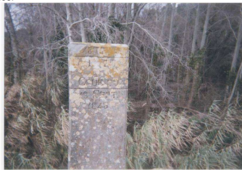
Figure 2 : Laisses de crue 1845 et 1875 sur le pont canal.
