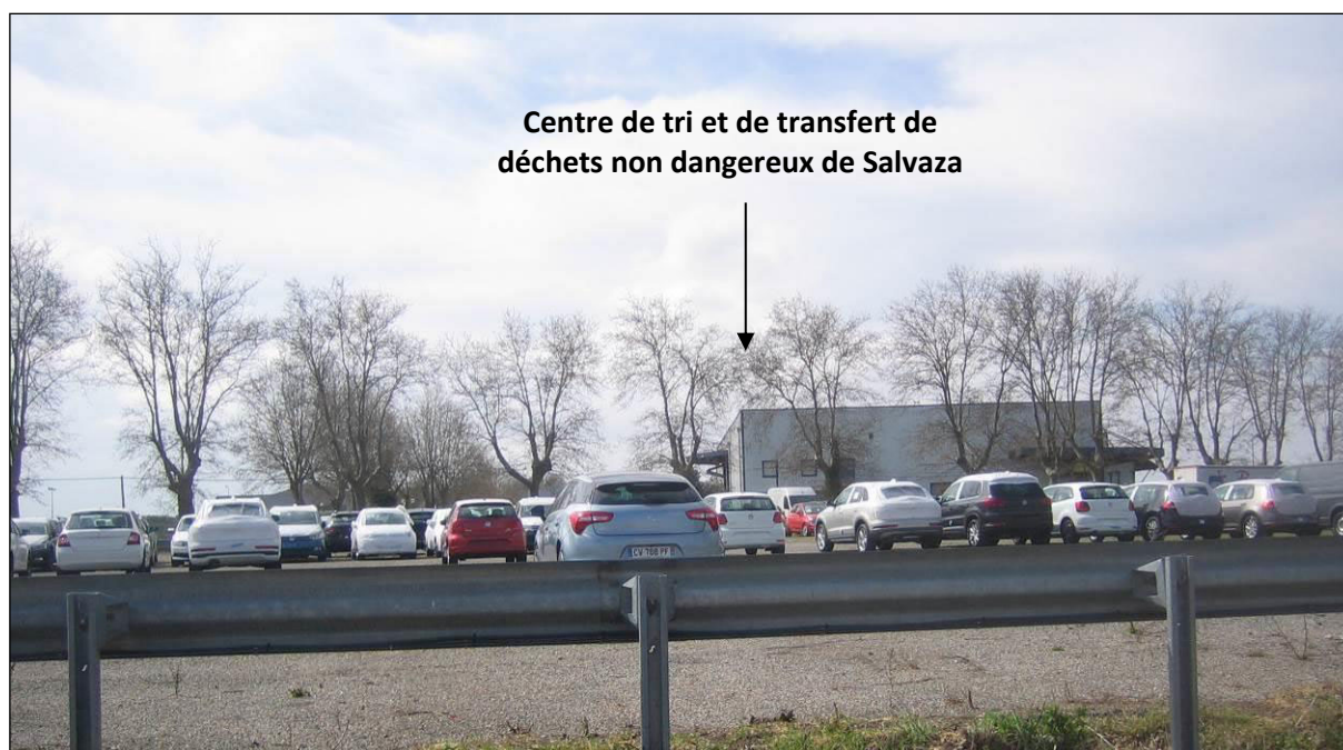
Figure 37 : Vue depuis la zone commerciale, rue Antoine Durand (prise de vue 9)
