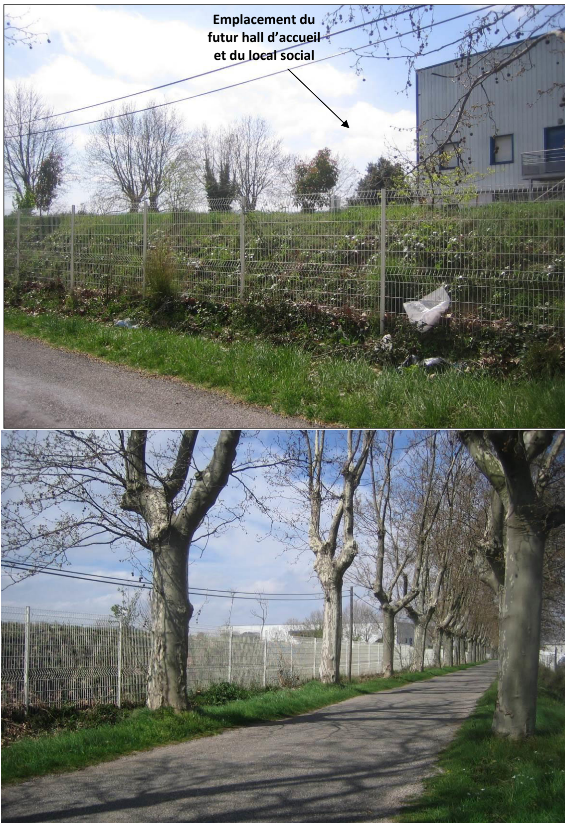
Figure 32 : Vue du centre de tri de Salvaza depuis le chemin du Galinier (prises de vue 3 et 4)
