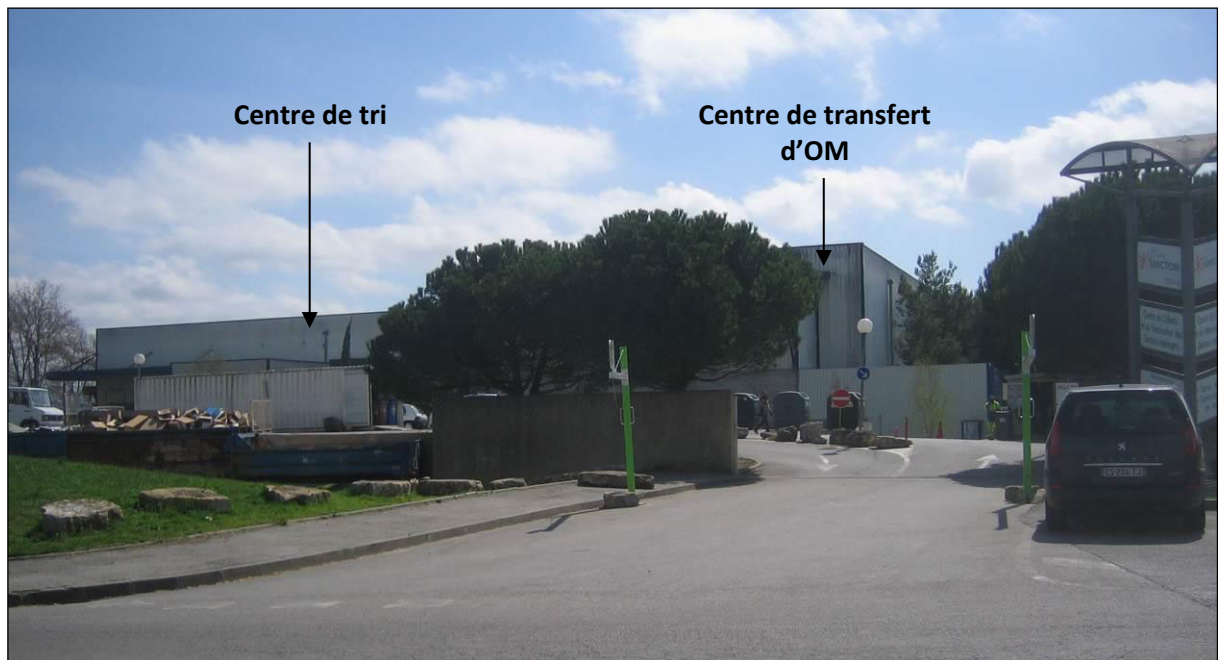
Figure 29 : Vue de l'entrée du site de Salvaza par le Boulevard Fafeur (prise de vue 1)
