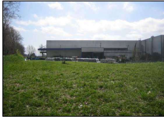
Figure 63 : Vue de la nouvelle parcelle au nord depuis le point de vue n°1
