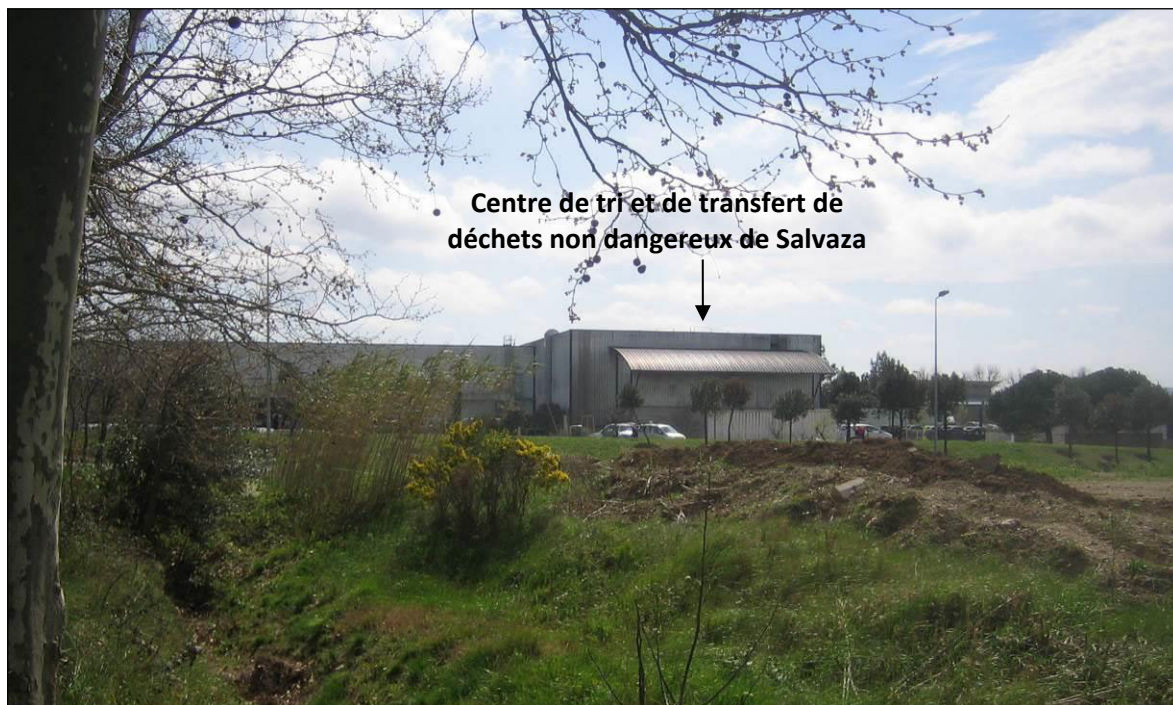
Figure 34 : Vue sur le centre de tri et de traitement des déchets non dangereux depuis l’habitation situé au nord du boulevard Fafeur (prise de vue 6)
