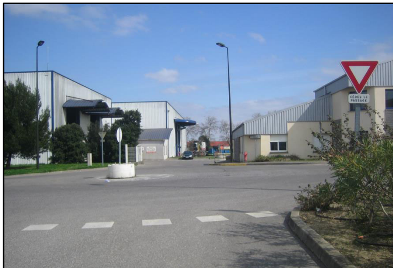
Figure 78 : Vue depuis l'intérieur du site
