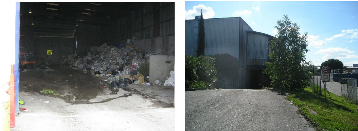
Figure 10 : A gauche : Bâtiment de transfert des déchets d'ordures ménagères – A droite : Aire de chargement des semi-remorques
