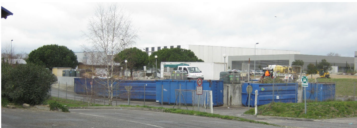
Figure 18 : Vue sur la déchèterie (depuis le centre de tri)
