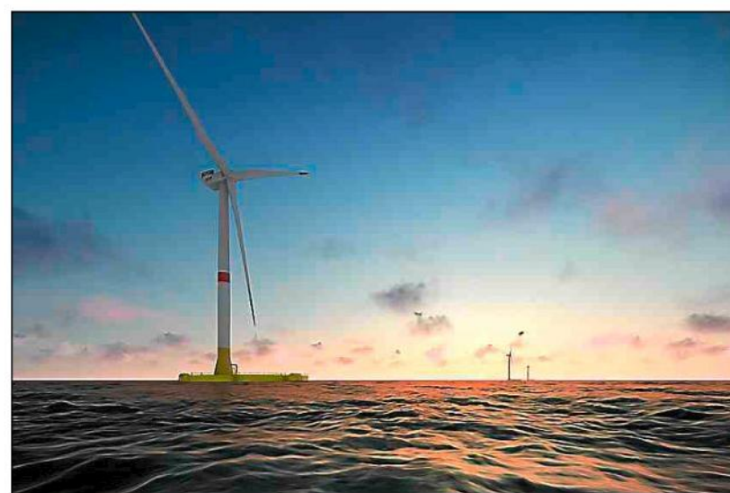
Un projet d'ampleur qui nécessite des délais.
