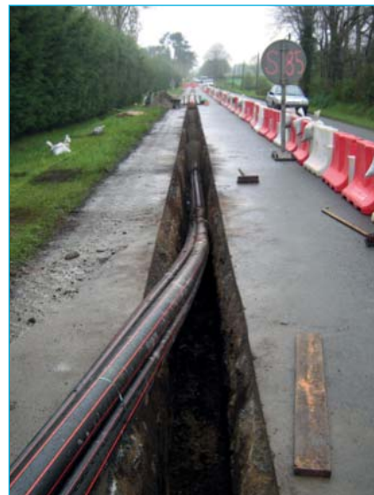
Exemple de pose en fourreaux PEHD sous voirie
