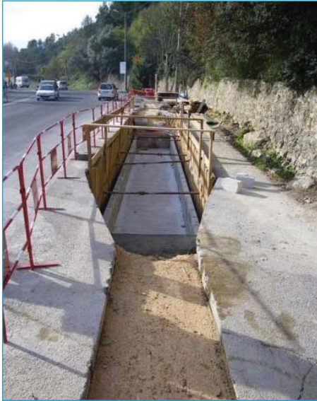
Construction du génie civil d'une chambre de jonction
