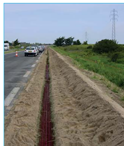
Exemple de tranchée sous accotement de voirie
