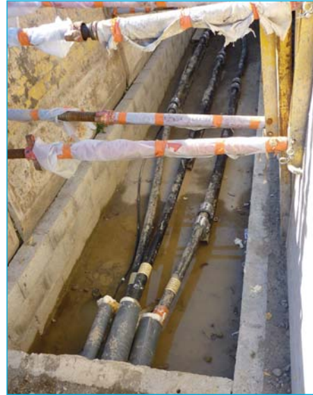
Jonction des câbles dans la chambre
