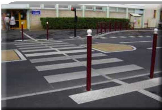
Les traversées piétonnes doivent comporter un dispositif tactile permettant aux piétons aveugles ou malvoyants de se rassurer sur le fait qu'ils sont bien sur ces traversées.
