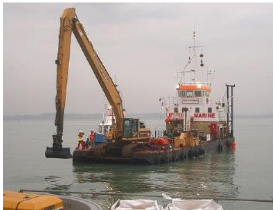
Figure 30 : Exemple de barge excavatrice
