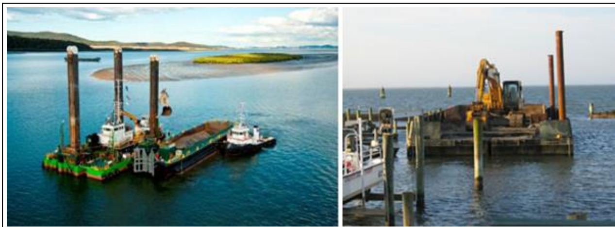
Figure 18 : A gauche : pelle rétro-caveuse, ici avec navire sablier et remorqueur ; à droite : pelle mécanique sur barge
