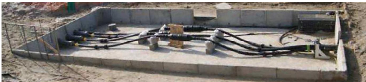
Figure 29 : Chambre de jonction d'atterrage en travaux
