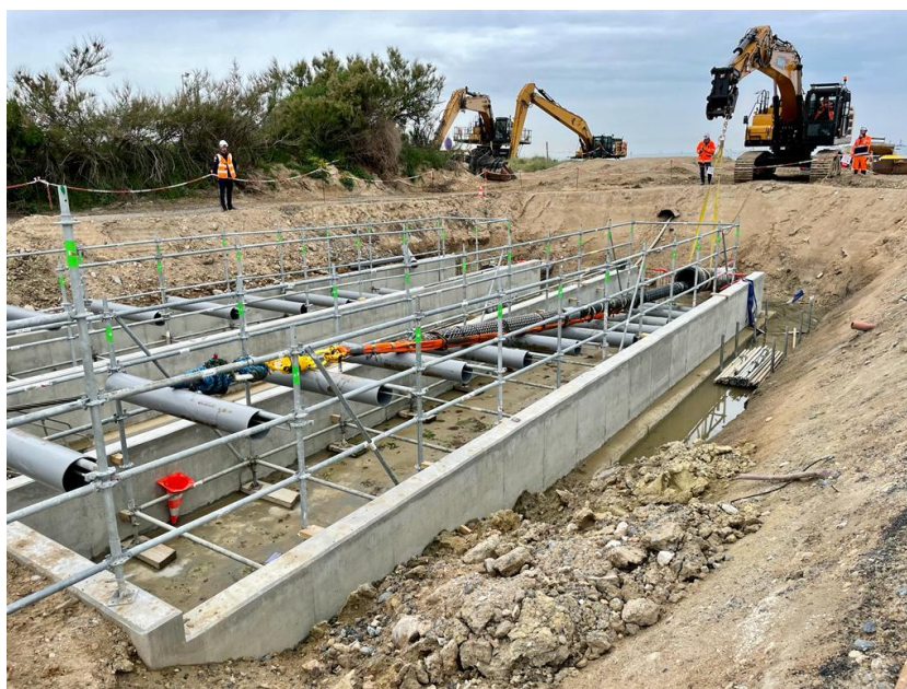
Figure 35 : Tirage au niveau de la chambre d'atterrage (Source : RTE)
