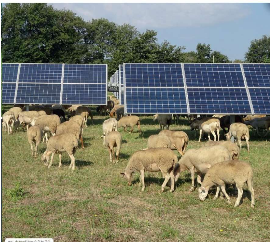
parc photovoltaïque du Soter (66)
