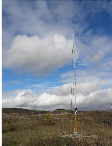
Figure 13. Stations météorologique installée au sud de la mine à ciel ouvert
