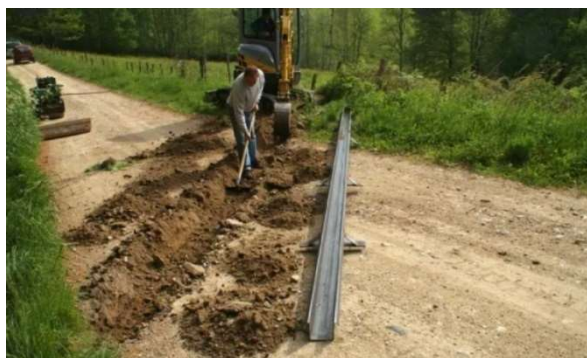
Exemples de rigoles anti-ravinement ou cunettes
