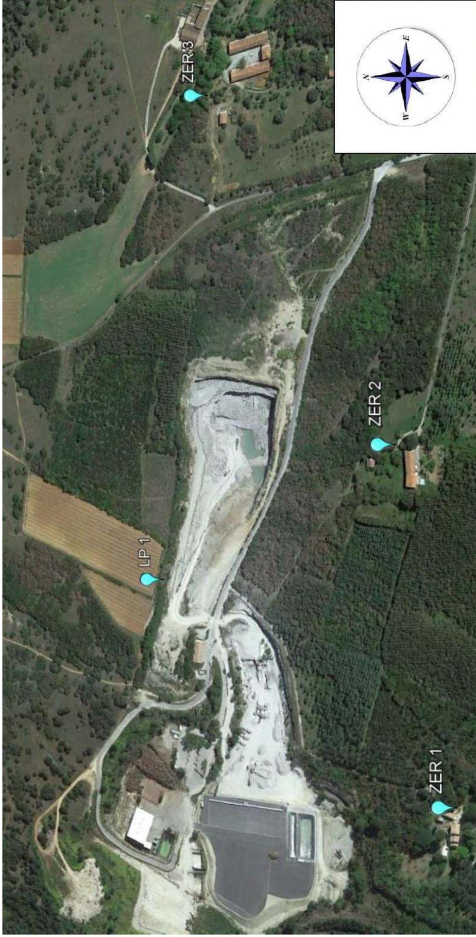
Figure 68. Implantation des points de mesure du niveau sonore
