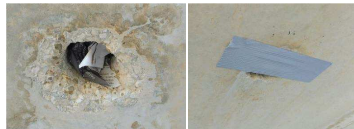
Illustration d'un drain colmaté au moyen de papier journal puis de Chatterton (Photo © Naturalia)
